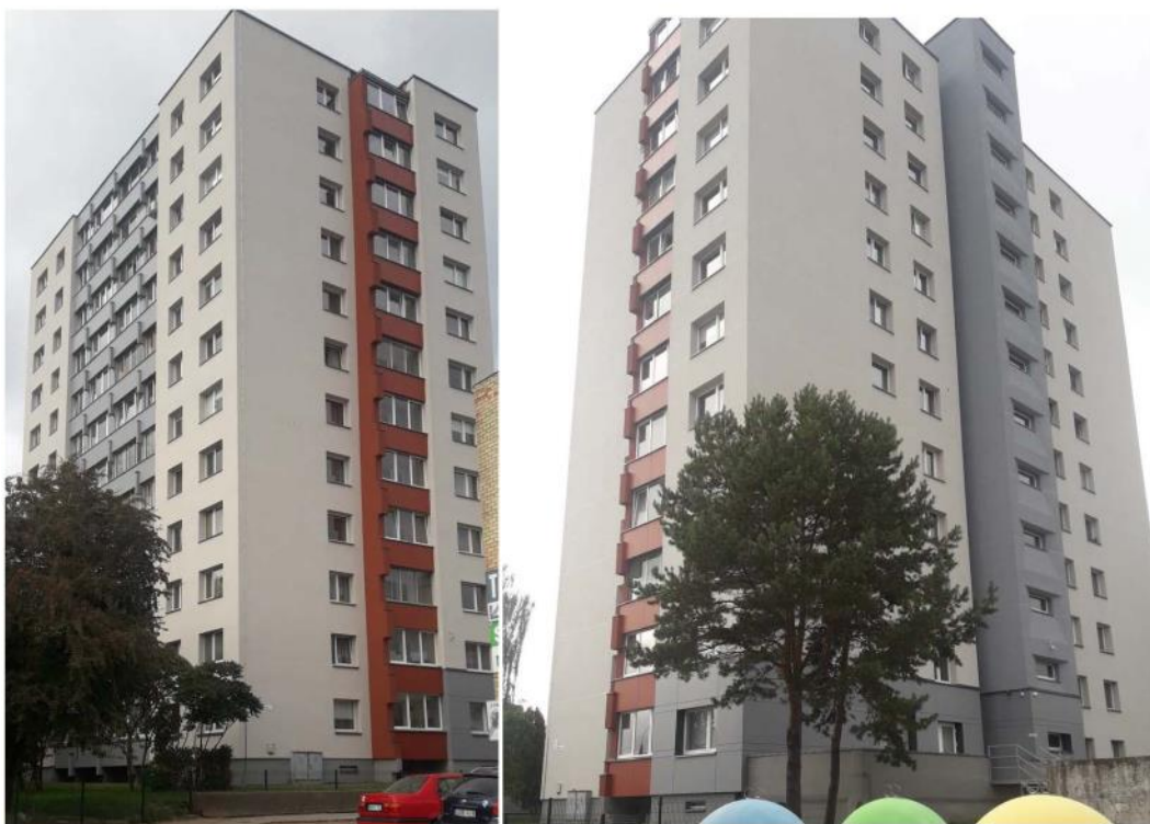
Fasadas apšiltintas putų polistirolu, apdaila – struktūrinis tinkas. Balkonai apšiltinti išorėje.
