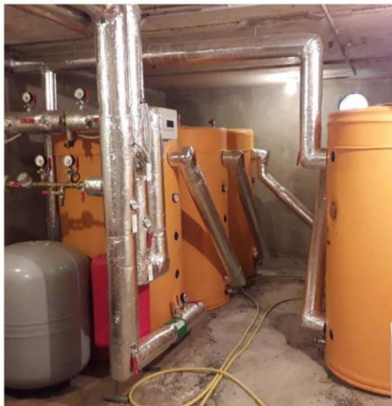
Šilumos punkte sumontuotos karšto vandens pašildymo akumuliacinės talpos
