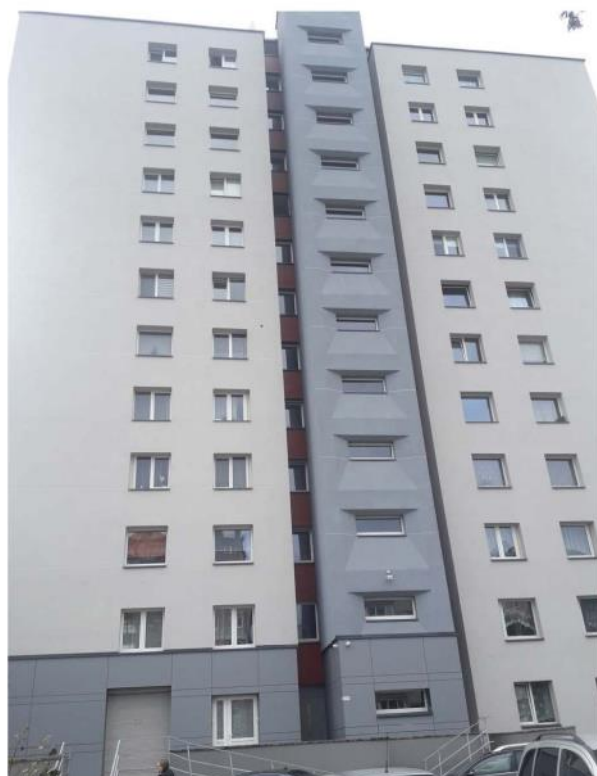
Pirmo aukšto sienos dėl mechaninio atsparumo apšiltintos įrengiant ventiliuojamą konstrukciją.
