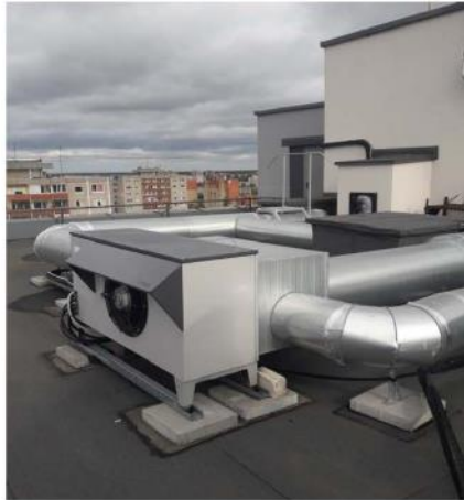
Iš butų pašalinamas oras ištraukiamas ventiliatoriumi per šilumos siurbį.
