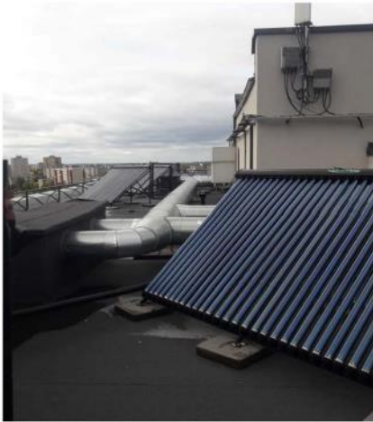
Visi vėdinimo kanalai sujungti ortakiais.
