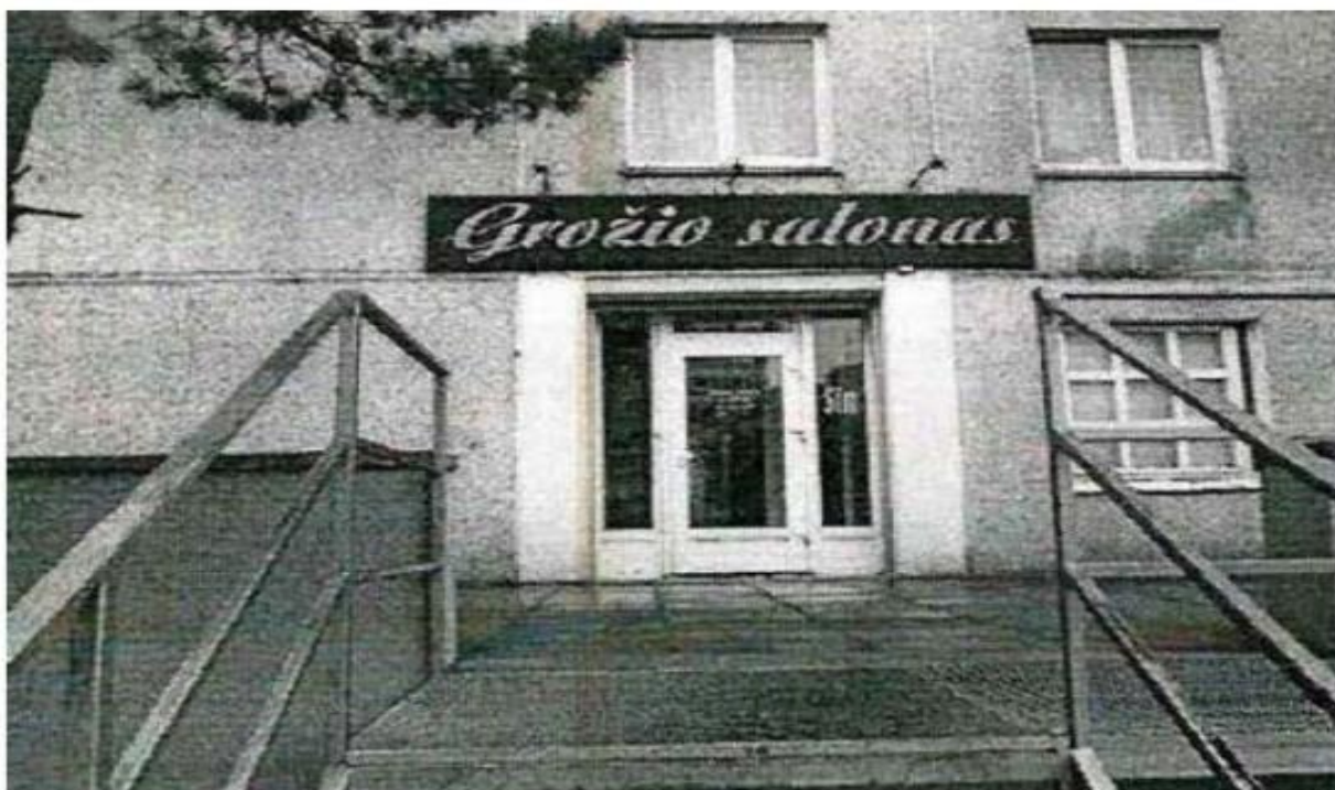
Namo įėjimas prieš renovaciją.
