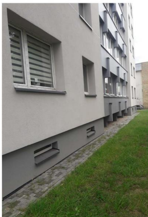
Istiklinti balkonai ,pakeisti rūsio langai , apšiltintas cokolis , įrengta nuogrinda.
